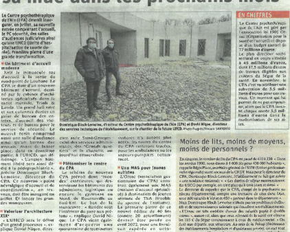
Travaux de rénovation du Centre psychiatrique de l'Ain.
